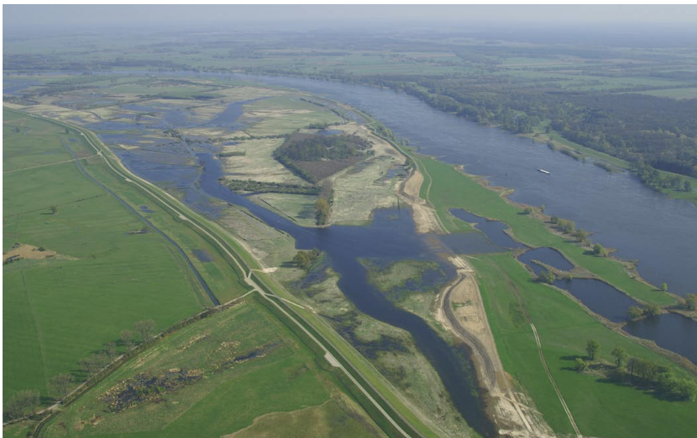
Deichrückverlegung an der Elbe bei Lenzen. Ein wegweisendes Projekt zur Verknüpfung von Hochwasserschutz, Gewässerentwicklung und Naturschutz an Bundeswasserstraßen. Foto: Katharina Nagel, BUND / Trägerverbund Burg Lenzen e.V.
