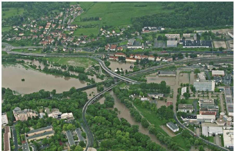
Feuerwehren, Hochwasserleitzentralen, Polizei und Rettungskräfte sollten möglichst nicht in hochwassergefährdeten Lagen angesiedelt sein oder werden (Hochwasserleitzentrale in Jena beim Hochwasser 2013). Foto: LaNaServ im Auftrag der Thüringer Landesanstalt für Umwelt und Geologie
