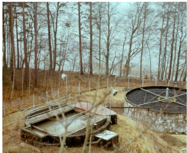
Abb. 5: Abwasserbehandlungsanlage (Emscherbrunnen) des KKW Rheinsberg am Nehmitzsee (in Betrieb von 1973-1978).
