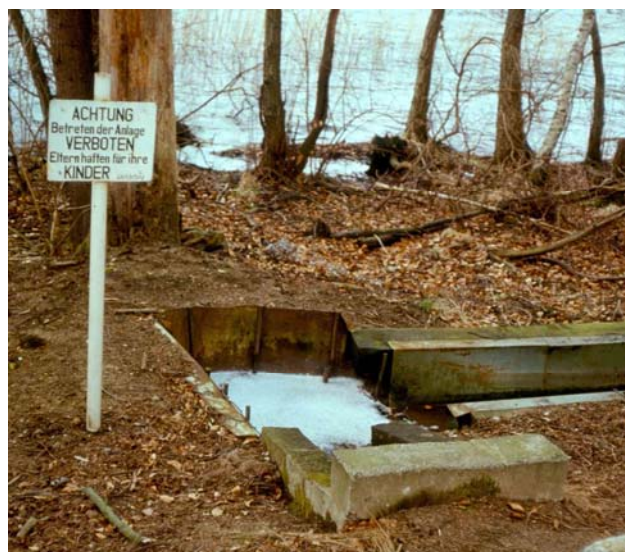
Abb. 6: Kläranlagenauslauf am Nehmitzsee (Fotos: W. Scheffler).
