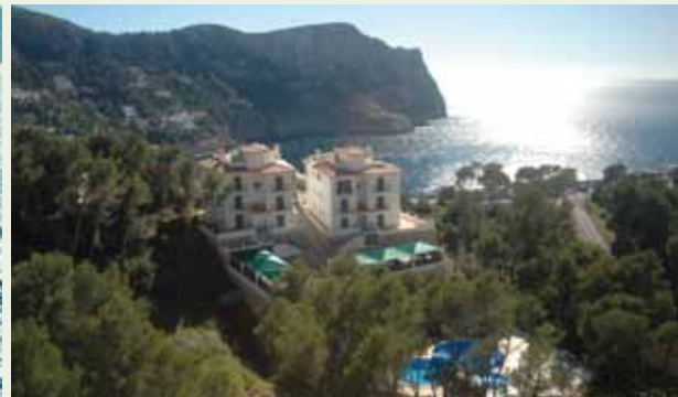
Illegale Bebauungen sind immer noch ein großes Problem auf Mallorca.
