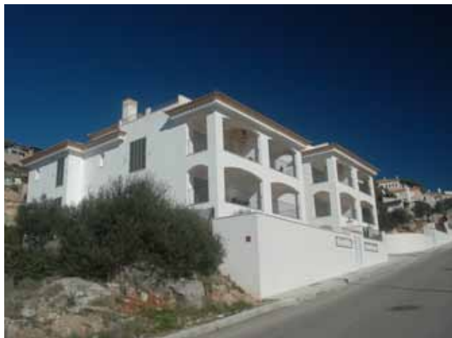
Diese illegal erbauten Häuser müssen nun lt. Gerichtsurteil abgerissen werden.
